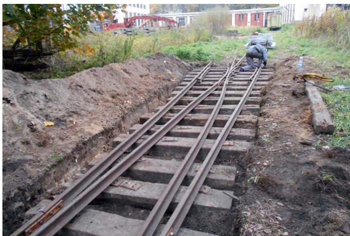
1. attēls. Sliežu ceļu remontdarbi Baložos 2014. gada oktobrī
